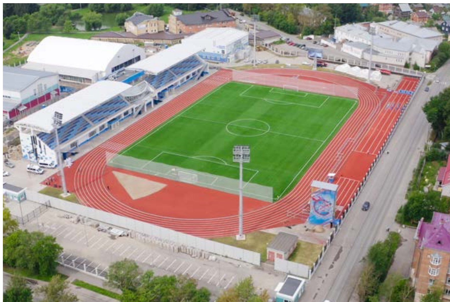
Реконструкция стадиона «Витязь» (открыт в 2023 году)
